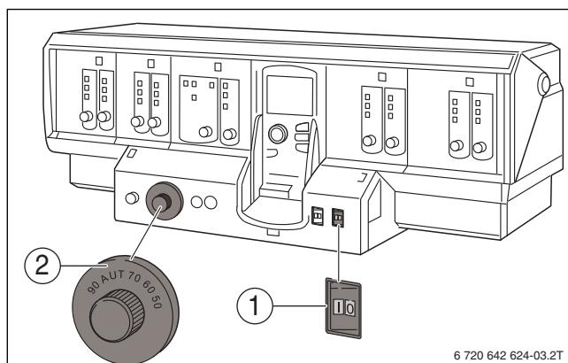
Рис. 32 Включение отопительной установки на системе управления (Logamatic 4000)
